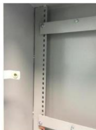
Figura 2: Detalhe da longarina e aplicação dos isoladores
