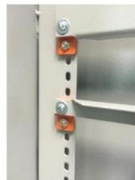
Figura 2: Detalhe da longarina e aplicação dos isoladores
